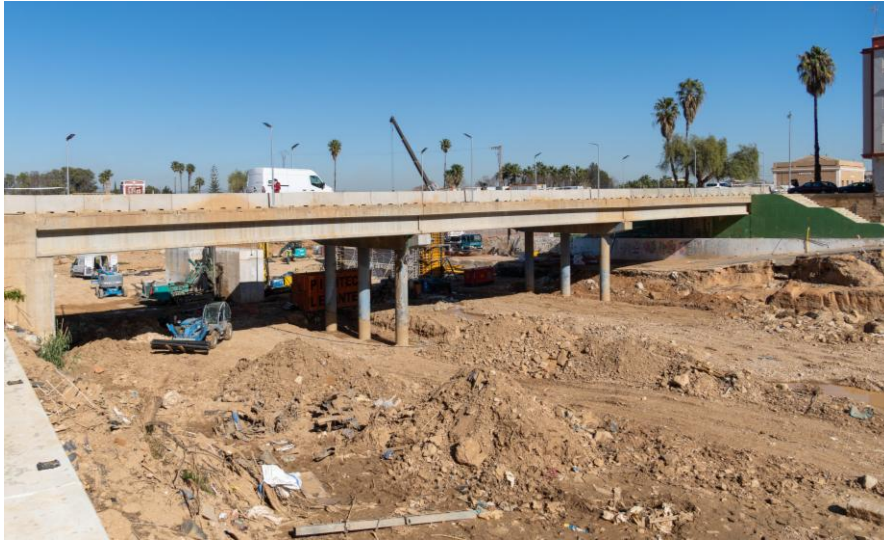
Paiporta-Puente Diputació CV-406
